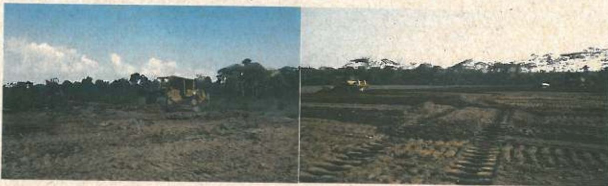
Macro nivelación de parcelas con tractores oruga
